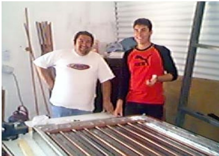
Autoconstrucción de colectores solares planos
