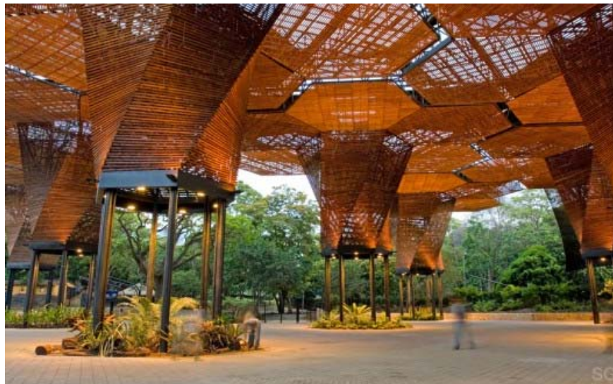
Orquideorama / Plan B Arquitectos + JPRCR Arquitectos
